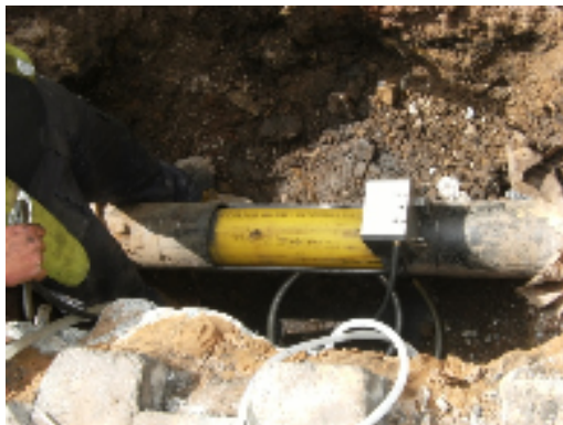
外周管上部のみの切断
