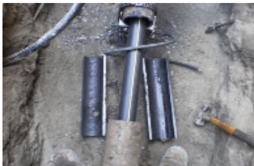
外周管の全体の切断
