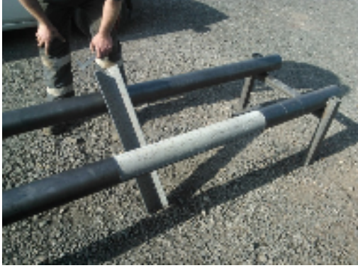
内部にグラウト(コンクリート)が入った管の切断
