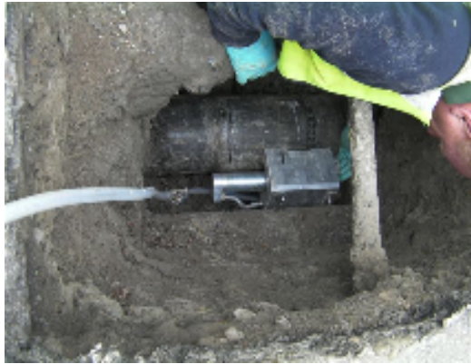
他埋設管がクロスした環境での立杭内施行の様子
